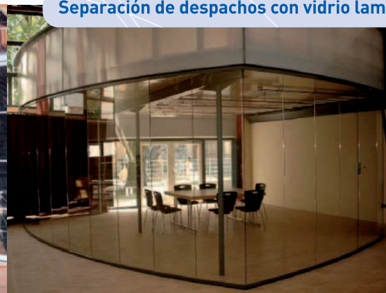
Separación de despachos con vidrio laminado o templado
