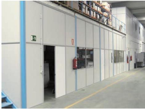
El tabique monovidrio o monopanel especialmente indicado para la separación en almacenes, fábricas, etc. Formado por una estructura de aluminio anodizada o lacada y paneles de 16 mm, vidrios de 4mm, policarbonatos, metacrilatos, etc.
