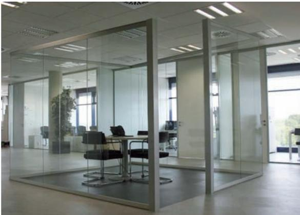
La nueva generación de mámparas divisorias, con máximo acristalamiento y mínimo aluminio, le caracteriza la utilización de vidrios laminados de 6+6 mm o 5+5 mm y vidrios templados de 10 mm en las puertas, que unidos al gran espesor de los perfiles de aluminio garantizan una insonorización y estabilidad perfectas.
